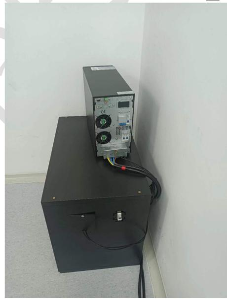
UPS和稳压器, 稳压器和实验桌排插间接线为6mm<sup>2</sup>铜线连接。准备至少 9 个国标 10A 的三孔插座供电脑、显示器、打印机及仪器使用。
